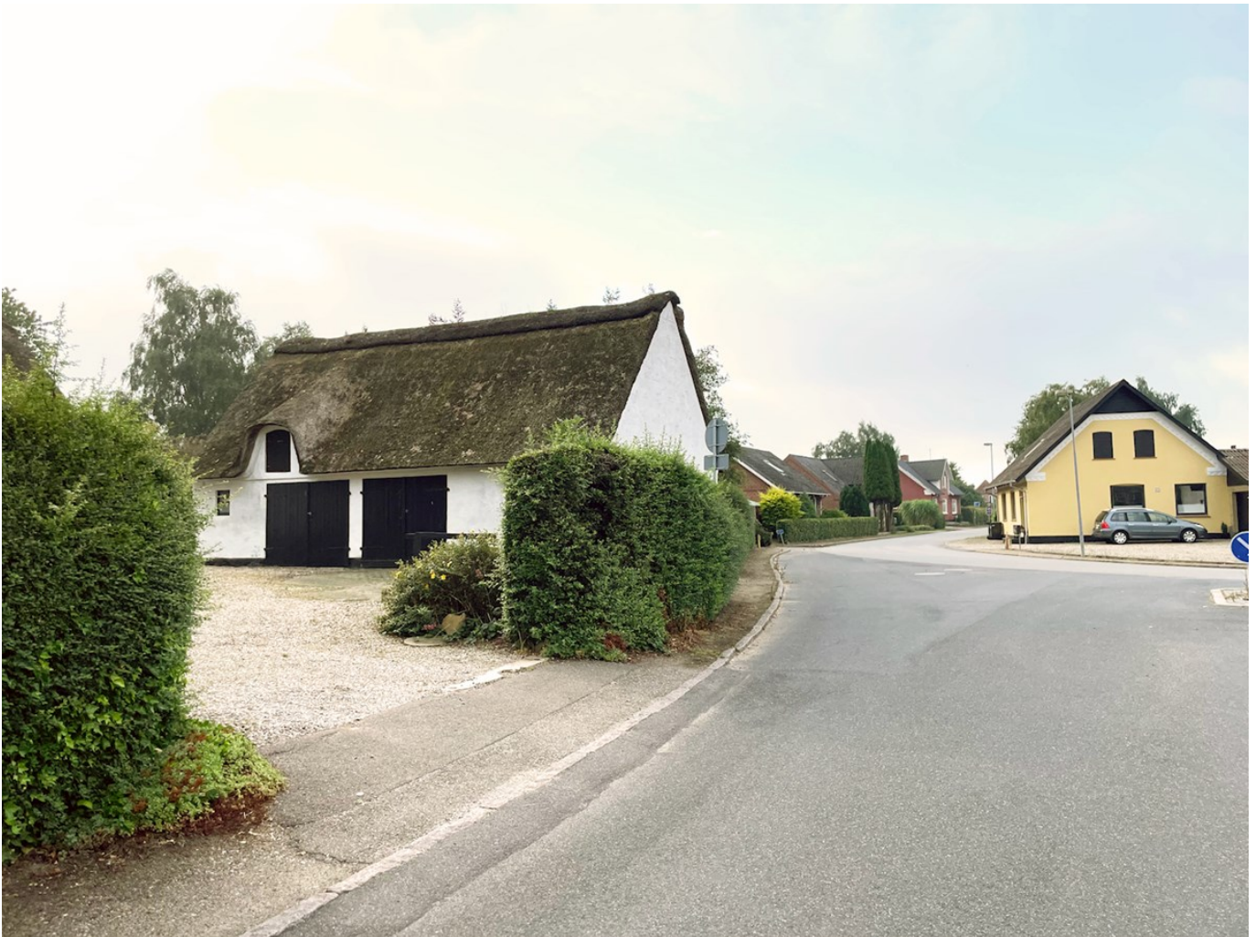
Billede fra Tønning landsby, som er udpeget til et værdifuldt kulturmiljø i eksisterende kommuneplan 2021-33. Tønning Landsby
